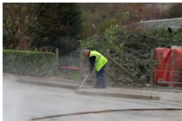
Afin de sécuriser la rue Goubermoulins, le stationnement est modifié, des bordures installées et les trottoirs élargis.
